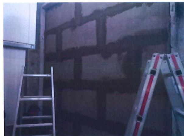
Bild A5.10: Fertigstellung der inneren Plattenlage sowie Verspachtelung der Plattenfuge.
