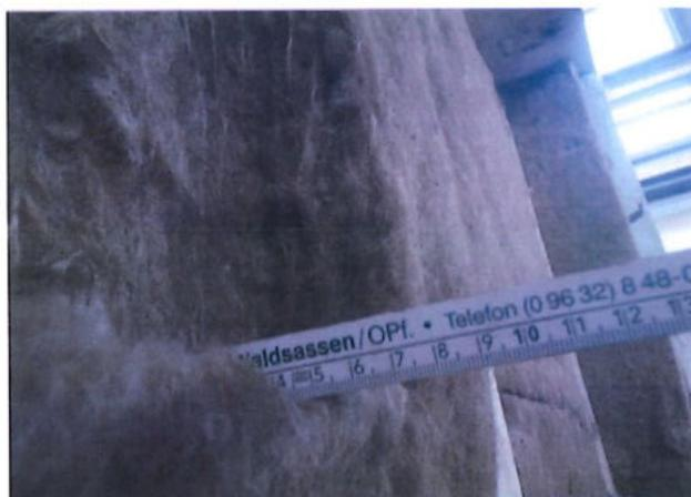
Bild A5.9: Aussetzen der Gefachdämmung zur Vorbereitung der Dosenhinterlegung.
