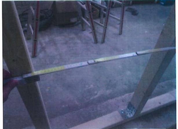
Bild A5.2: Darstellung Achsabstand der Holzständer  $a = 625 \text{ mm}$ .
