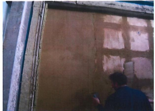
Bild A5.6: Putzauftrag Unterputz „AGATON Lehm Oberputz“ Lehmputzmörtel mit Gewebeeinlage Glasfasergewebe MAXIT PS 4 mm x 4 mm.
