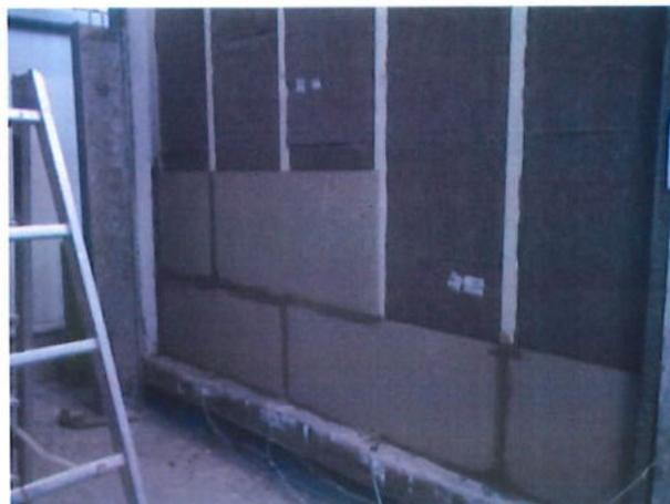
Bild A5.8: Einsetzen der Gefachdämmung „Thermo Jute“ mit  $d = 80$  mm sowie Montage der inneren Plattenlage „Lemix 2.0“ mit  $d = 16$  mm.
