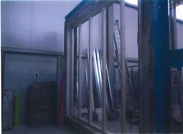
Bild A5.1: Montage der Holz-Tragkonstruktion mit Ständerquerschnitt  $b \times t = 60 \text{ mm} \times 80 \text{ mm}$ .
