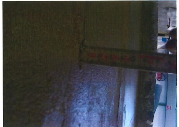
Bild A5.8: Auftragsdicke Unterputz ca. 3 mm.
