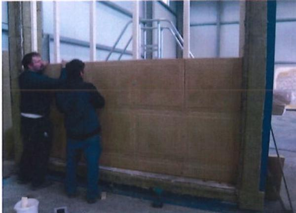
Bild A5.3: Montage der feuerseitigen Bekleidungs-lage bestehend aus  $d = 22$  mm dicker Lehm-
