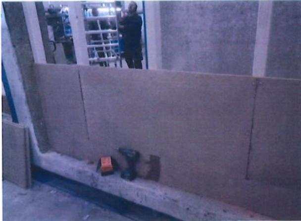
Bild A5.3: Montage der inneren Plattenlage Lehmplatte „Lemix 2.0“ mit  $d = 16 \text{ mm}$ .
