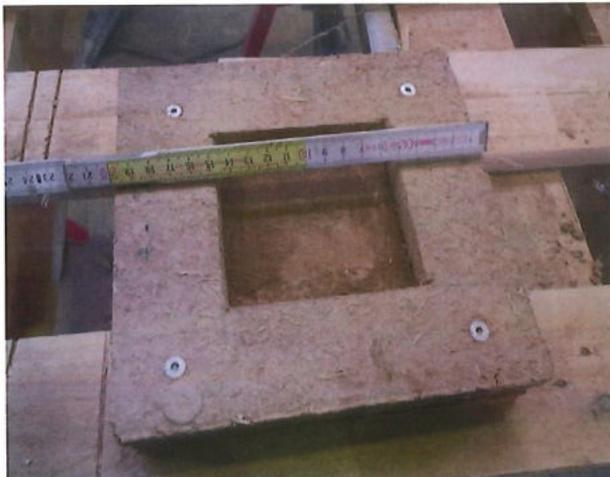
Bild A5.5: Hinterlegung ELT-Leerdose.
