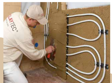
L'enduit de base est taloché à fleur de conduites.
