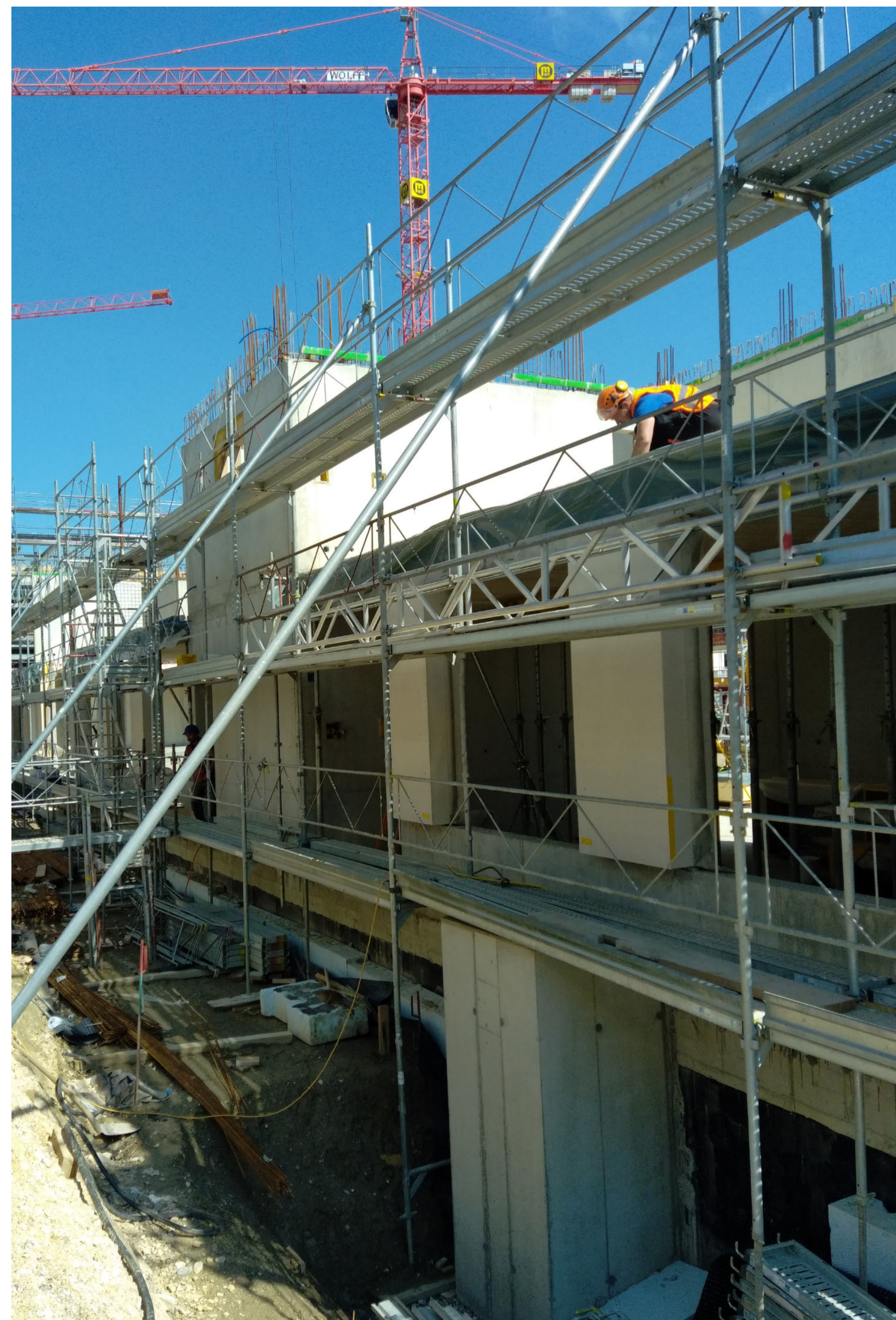
En haut : Insufflation de la paille ISO-Stroh dans les caissons bois/Fermacell (JPF-DUCRET) En bas à gauche : Les murs préfabriqués en atelier (JPF-DUCRET) Ci-contre et ci-dessus : Les murs préfabriqués posés sur site et pose de la partie bois du plancher collaborant bois/béton (ATBA)
