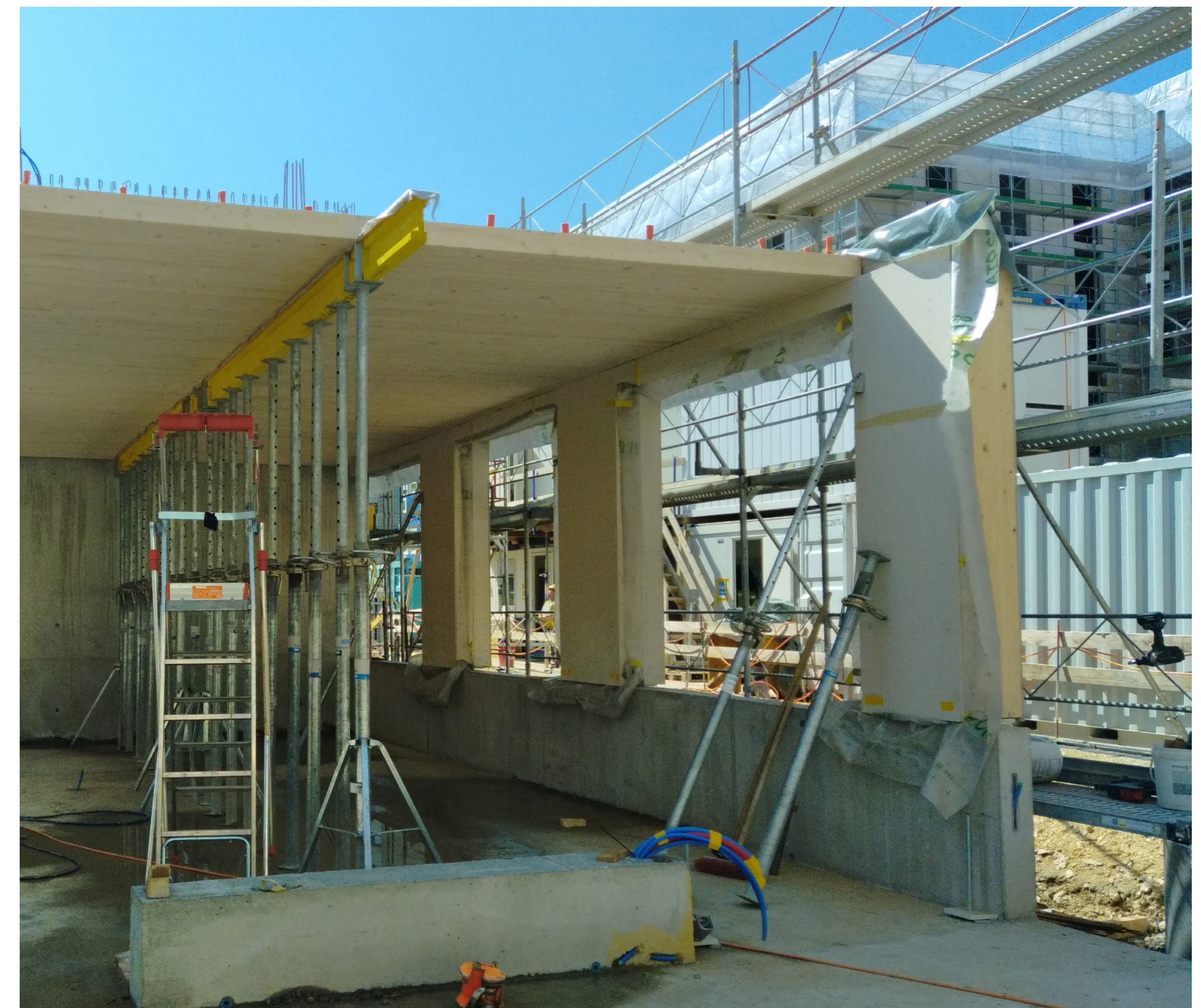
En haut : Insufflation de la paille ISO-Stroh dans les caissons bois/Fermacell (JPF-DUCRET) En bas à gauche : Les murs préfabriqués en atelier (JPF-DUCRET) Ci-contre et ci-dessus : Les murs préfabriqués posés sur site et pose de la partie bois du plancher collaborant bois/béton (ATBA)
