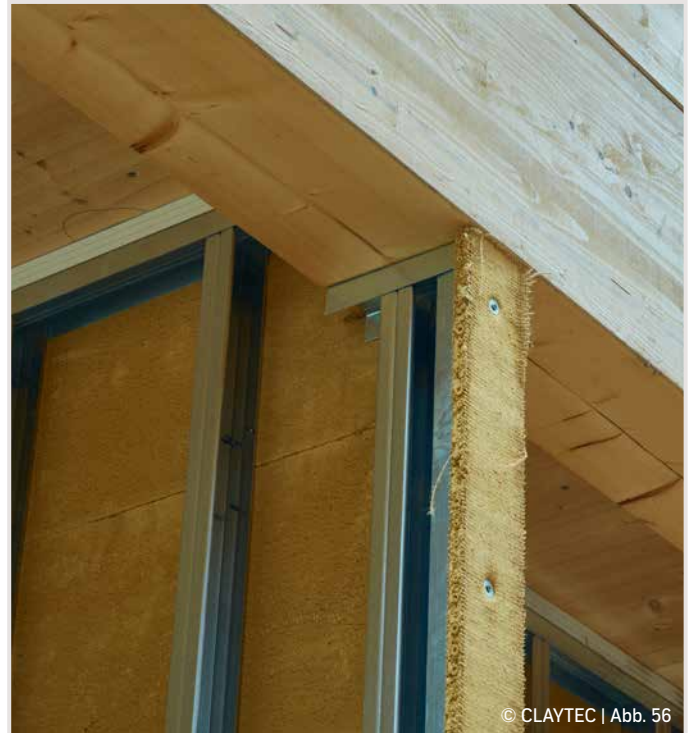
Anschlüsse an Decke und Unterzug
