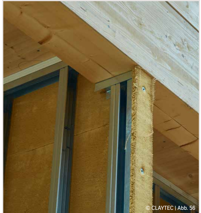
Anschlüsse an Decke und Unterzug
